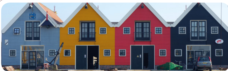
Auch kleine »Hallen« können gerade in Städten eine Bedeutung haben – als Verteilzentrum für Waren, die beispielsweise mit dem Fahrrad weiter ausgeliefert werden.
