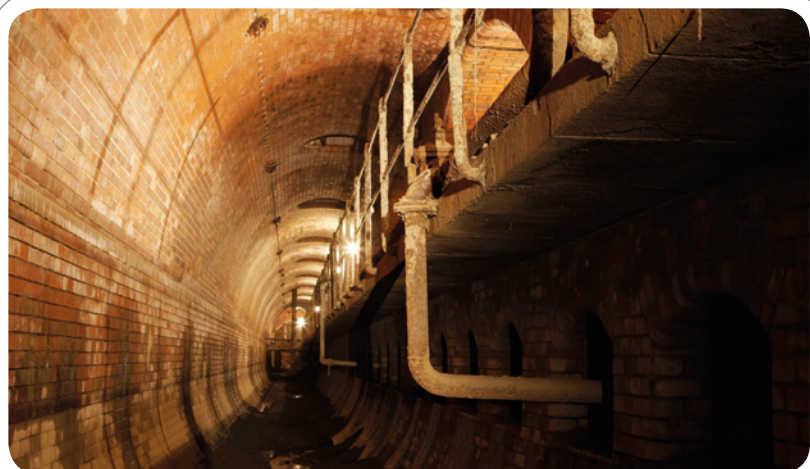
BGI Analytics ermöglicht umfassende Analyse und Bewertung von Versorgungsnetzen städtischer Kommunen nach Ausfallrisiko und Wichtigkeit. Die Modelle beruhen dabei auf der jahrzehntelangen Erfahrung der Fichtner Gruppe auf diesem Gebiet.
